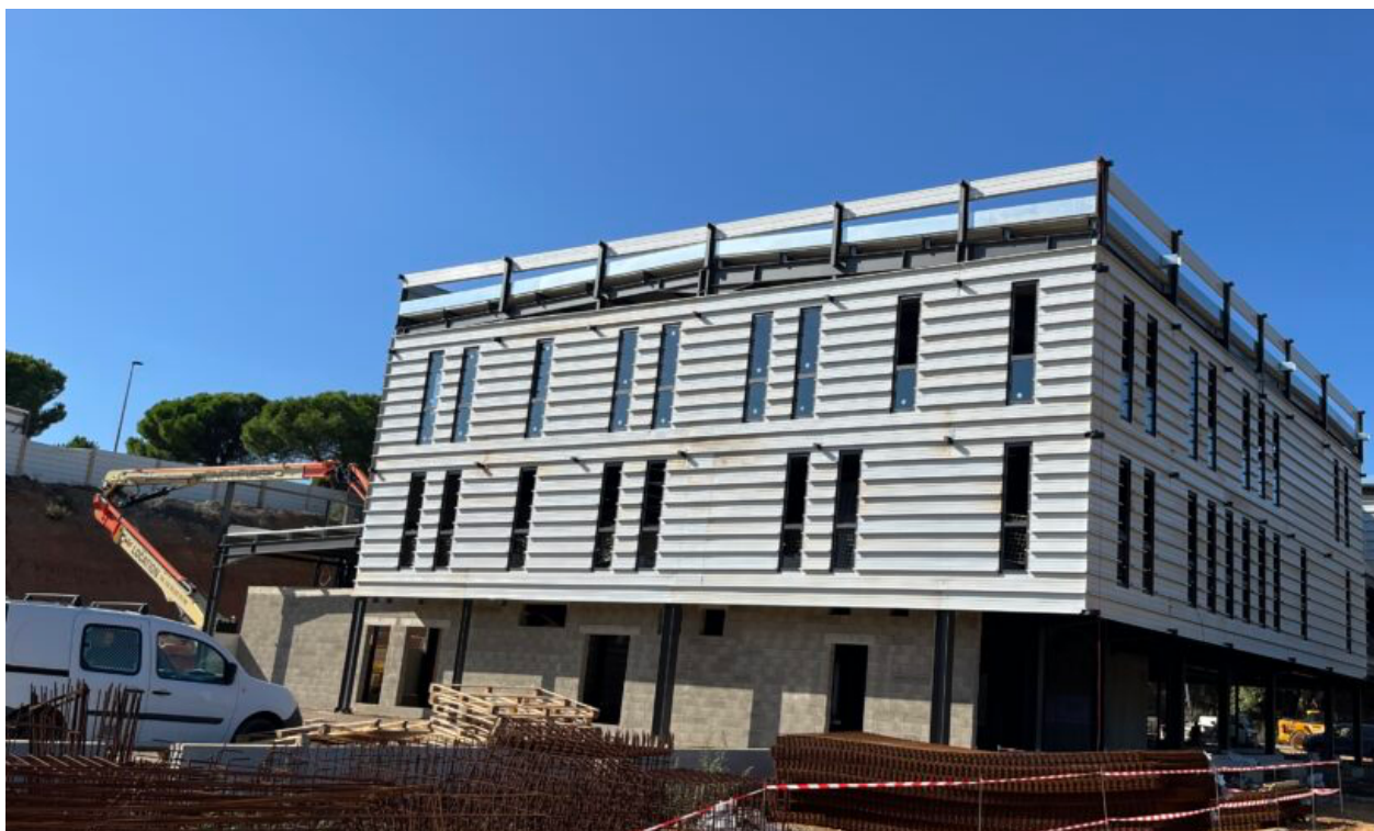
Chantier en cours du nouveau Centre technique - Parc d'activités d'Erbaiolu
